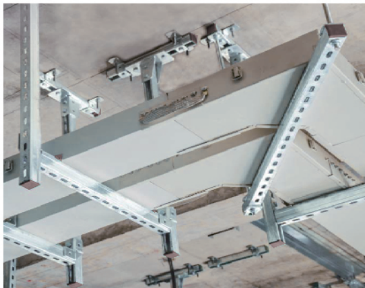
刚性支架的安装方法
