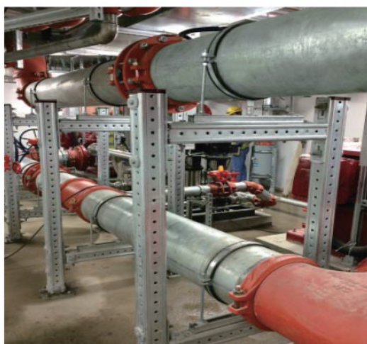
刚性支架的安装方法
