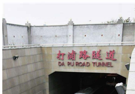
06 上海黄浦江隧道 机械液压可调轴流式隧道风机
