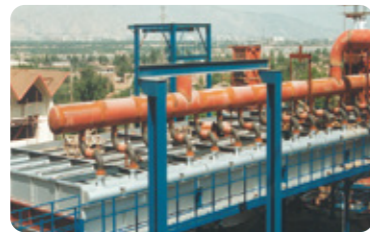
兰州炼油厂连续重整装置
