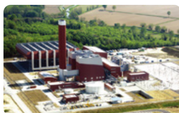
意大利直接空冷系统联合循环电厂
