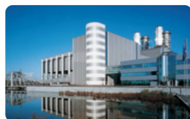
比利时布鲁日直接空冷A-frame结构电厂
