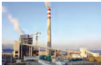
广东阳西电厂AGC储能调频项目
