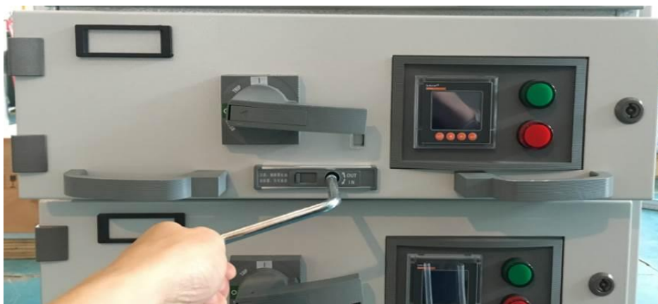
2、顺时针转动摇杆, 从隔离位置经试验位置至连接位置
