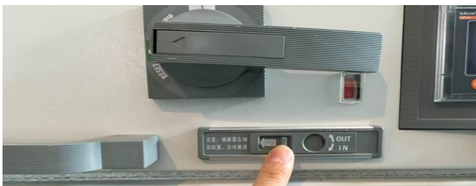
3、取出摇杆，向左拨动移动钮，封闭摇杆孔。
