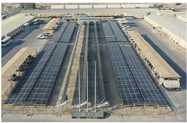
应用项目 巴基斯坦 20MW 光伏电站
