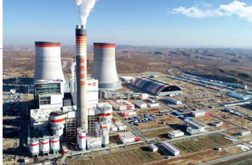
国内首个百万间接空冷项目全投运
