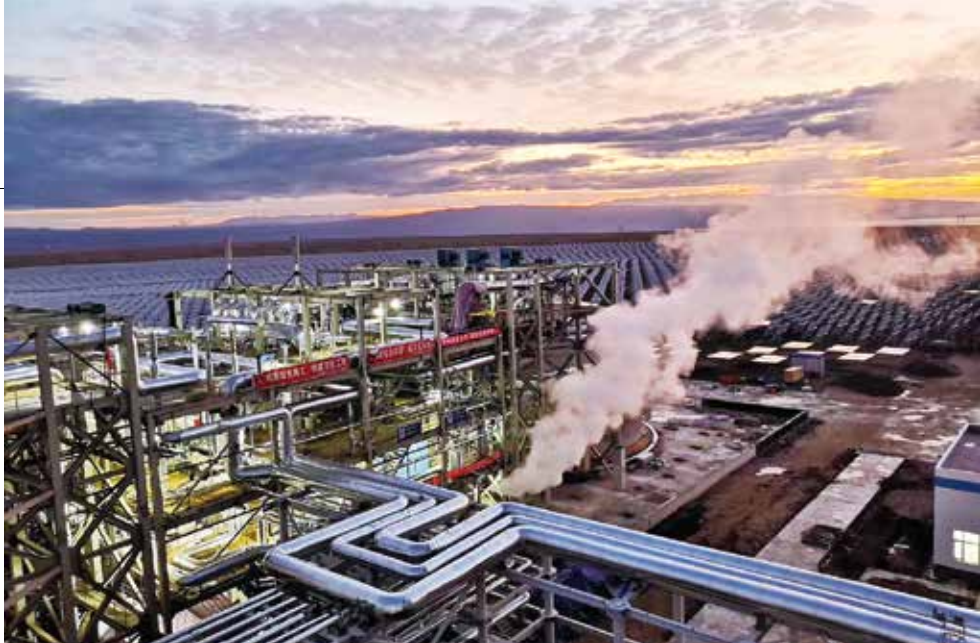
自主蒸发系统 青海熔盐塔式光热并网
