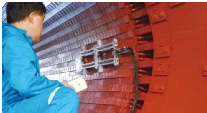
► 让机器人给 发电机定子 做“胃镜”
