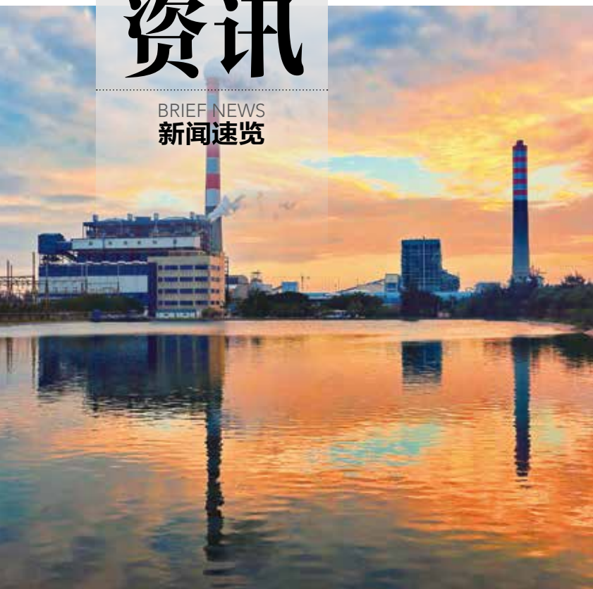
▲ 国投湄洲湾第二发电厂2×1000MW机组
