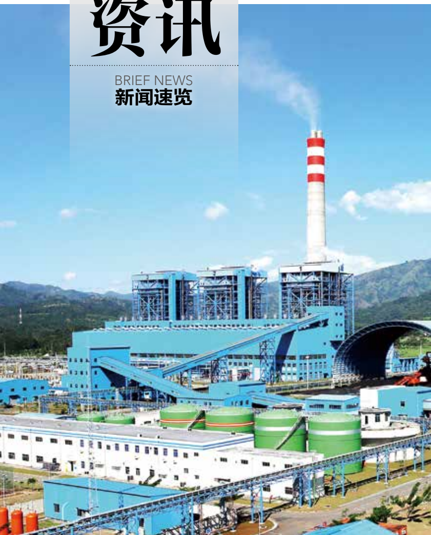
▲ 公主港项目全貌
